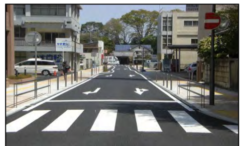
市道 202 号線整備事業（歩車道整備・電線地中化等）
